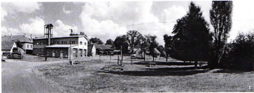
Obr. 1 - celkový pohled na lokalitu severním směrem. Snímek dokládá vizuální dominanci zbrojnice na prostranství, stejně jako jeho prostorovou neohrazenost. Napravo vidíme nesourodou, nahodile vysazenou zeleň. V popředí vybavení dětského hřiště: kolotoč, houpačky a klouzačka.
